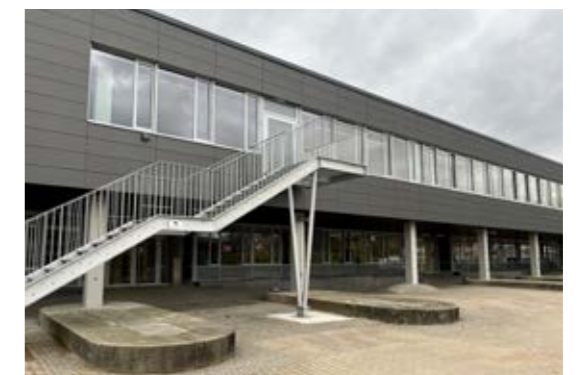
Oben: Alte Fassade Unten: Neue Fassade inklusive neuer Fluchttreppe
